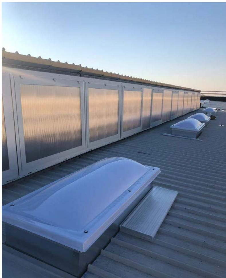
l'applicazione alla struttura. L'assenza di profili di giunzione, che rende la superficie di aspetto pressoché uniforme, ne fa la soluzione ideale per realizzare tamponamenti esterni verticali o inclinati, ma anche divisori interni in edifici industriali, edifici commerciali e impianti sportivi.
